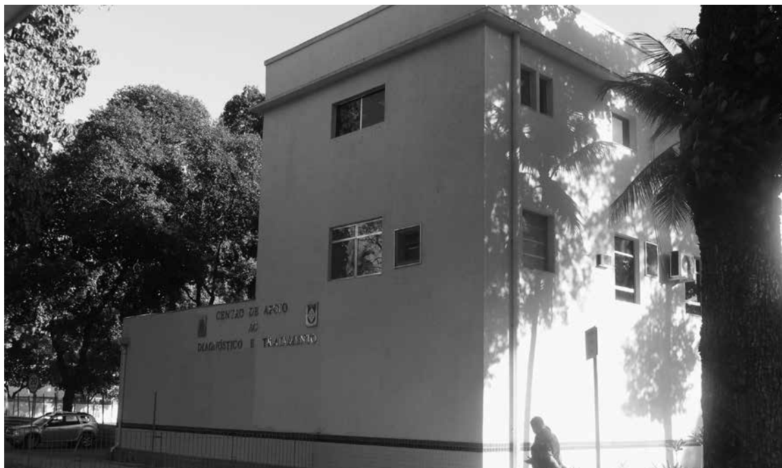
No destaque: local da fachada lateral esquerda do HCE onde havia uma entrada, que foi fechada. Fonte: Arquivo CNV
